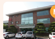
N3 스포츠컴플렉스 실내 암벽장, 조깅트랙, 골프연습장, 헬스장
